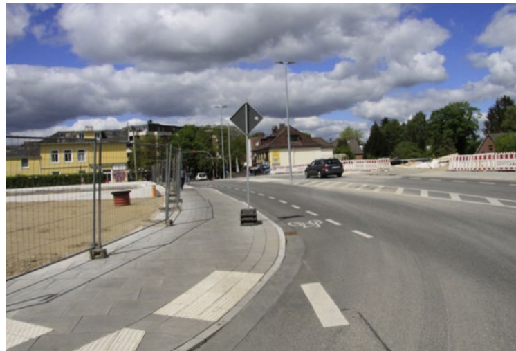
Abb. 27: Autobahndeckel im Bereich der Frohmestraße
